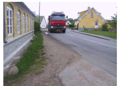
Der er lavet et fortov på Knebel Bygade og nye vejbelægninger.
