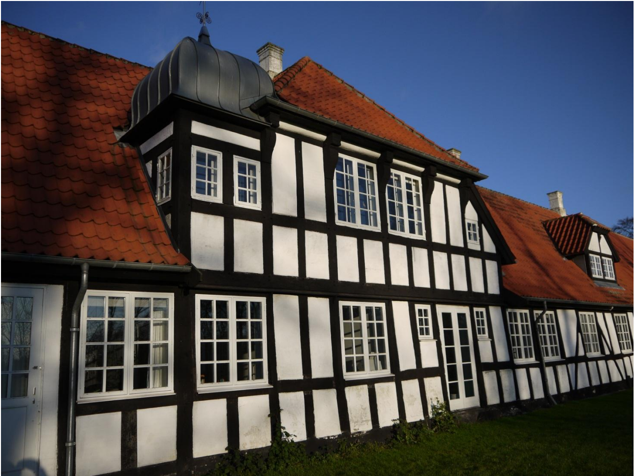
Midterfløjen på Kalø's hovedbygning, parksiden. Foto VFH dec. 2011
