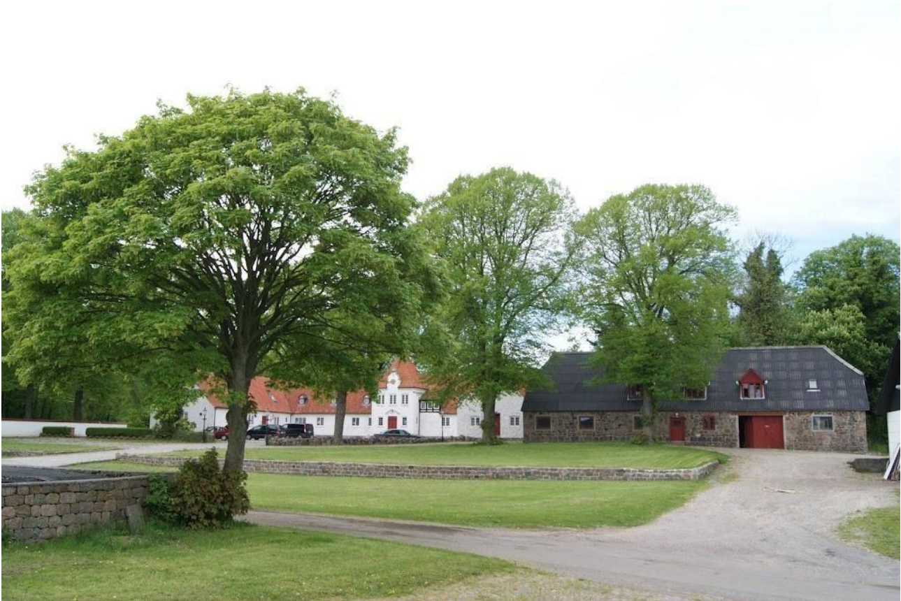
Den store gårdsplads på Isgaard med landevejen forrest i billedet. Hovedbygningen bagerst til venstre.
