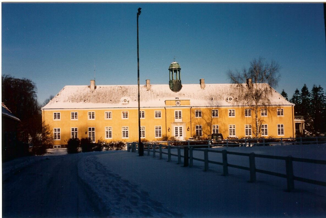
Møllerups hovedbygning, foto 1998. Ridebanen i forgrunden til højre, hestestalden til venstre. Uden for billedet, til højre, ligger den tidligere Hubertus-kro, der oprindeligt var bygget som studestald.
