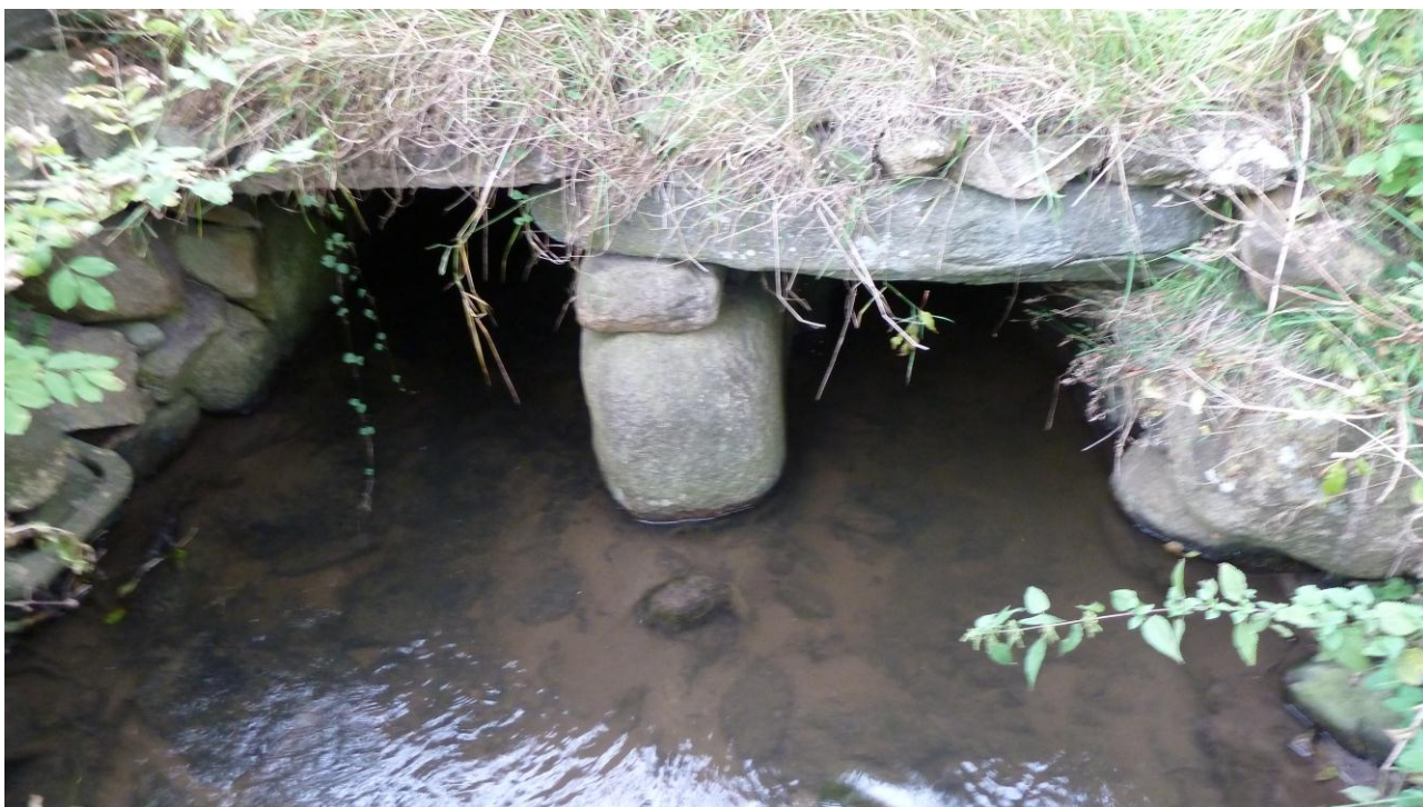
1. Stenkisten set fra sydsiden. Den kan ikke ses fra nordsiden, da vejen her er udvidet, så stenkisten først begynder et stykke inde under vejen.
