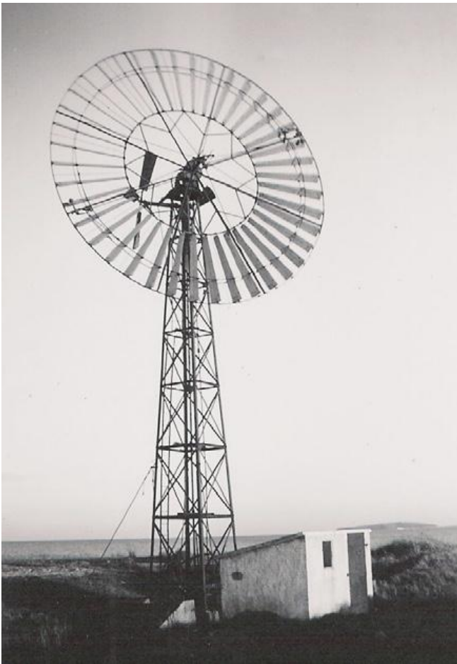
Vindmøllen fra 1899, fungerede indtil den nye afvanding i 1940'erne. Pumpehuset er i dag læskur for fårene. Fra Kjeld Hansen: Folk og Fortællinger, 2001.
